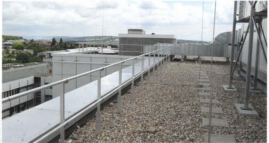
Industriedach heute mit viel Technikaufbauten, die gewartet werden müssen. Beachtenswert die mustergültige Arbeitsplatzsicherung.
