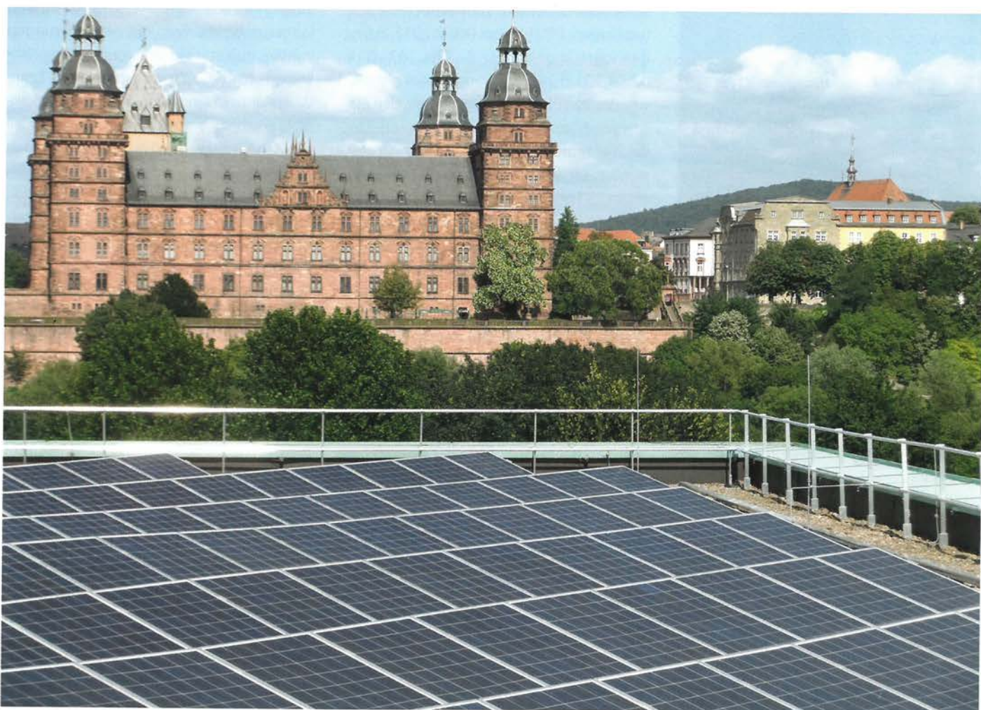
Dachfläche vollständig mit Photovoltaik genutzt und dennoch gegen Absturz bei Wartungsarbeiten gesichert.
