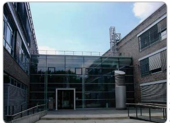
Abb. 2: Absturzsicherungen und sicherer Zugang an einem Flachdach
